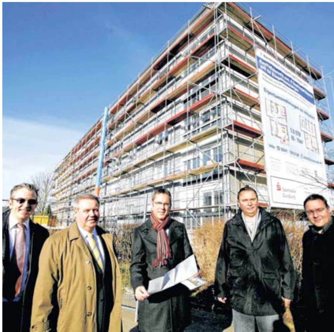
Ortstermin an der Eschenstraße: Eine Delegation der Stadtverwaltung mit Bürgermeister Hans-Theo Mennicken an der Spitze sah sich die Sanierungs-Fortschritte im ersten Bauabschnitt mit 44 Etagenwohnungen an. RP-FOTO: ARMIN FISCHER
